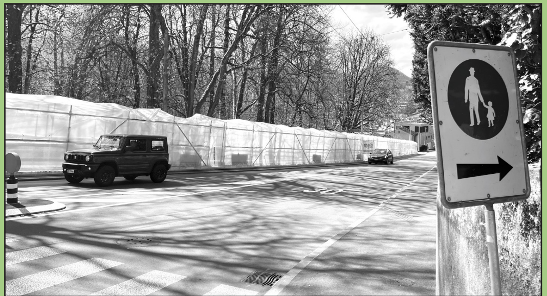
Eingehüllt wie ein Kunstwerk von Christo: Das Gelände beim alten Friedhof wird saniert.
