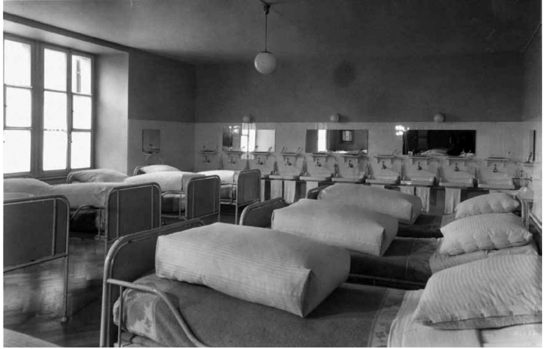
Schlaf- und Waschraum im Waisenhaus Luzern nach der Renovation 1937
